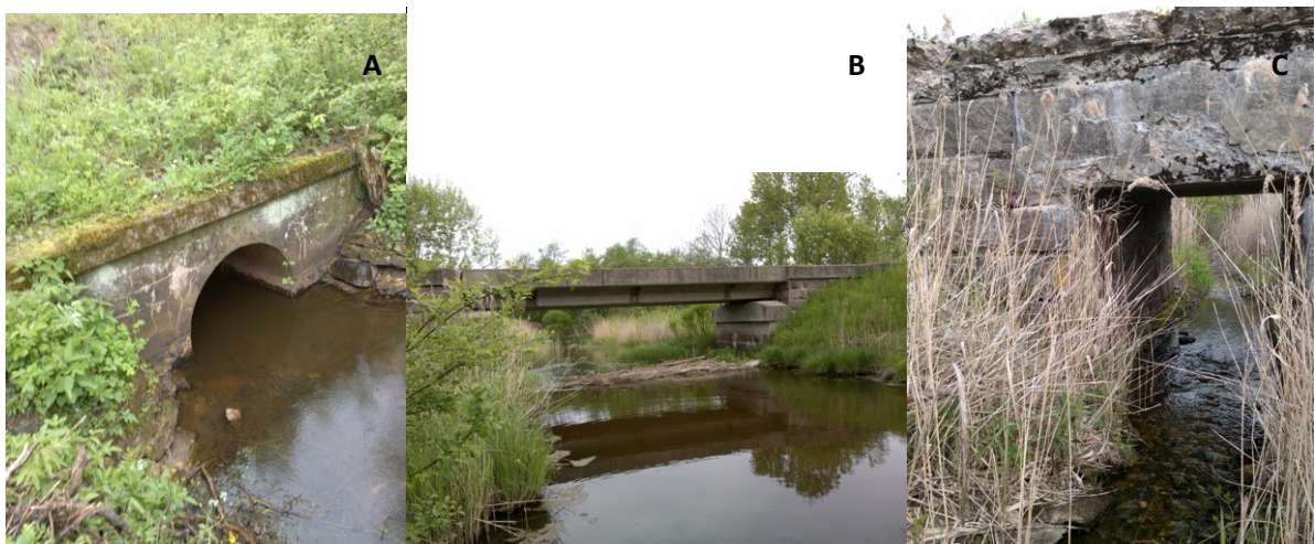
Fotod 3. Näiteid olemasolevatest raudteerajatistest, mida tuleb ümber ehitada, et need toimiksid kahepaiksete ja roomajate läbipääsudena. A) truup Ungru ojal, mille võiks asendada pikendatud silla või kallasradadega truubiga (koht 23a kaardil 6, ptk 3.7); B) sild Võnnu ojal, mis on kahepaiksetele väärtuslik talvitusveekogu ja rändekoridor (eriti kuna lähedal on tiik). Silda võiks pikenda, et tekiks paari meetri laiused kallasrajad (koht 14a kaardil 4, ptk 3.7); C) truup voolava veega ojal pole hea läbipääs, kuid kuna ojakaldad liikumiskoridoriks, võiks rajada kallasrajad või lähedusse lihtsad läbipääsud (koht 10a kaardil 3, ptk 3.7).
