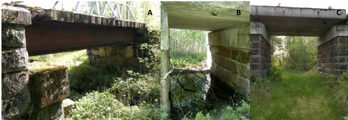
Fotod 2. Näiteid olemasolevatest raudteerajatistest, mis toimivad läbipääsuna praegusel kujul. A) kallasradadega ja laia põhjaga sild niiskes maastikus (koht 1a kaardil 1, ptk 3.7); B) üsna hea läbipääs kahepaiksetele, eriti kui põhja veidi tõsta, et tagada kuiv liikumisrada kõigil aastaegadel (koht 1c kaardil 1, ptk 3.7); C) hea loomapääs, väike metsatee, mis raudtee alt kulgeb, toimib maastikus loomi suunava elemendina (koht 8a kaardil 2, ptk 3.7).
